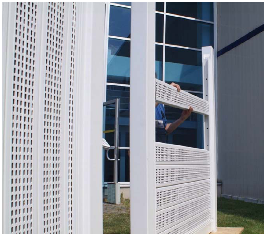
Rys. 5 Montaż paneli akustycznych jeden na drugim.
